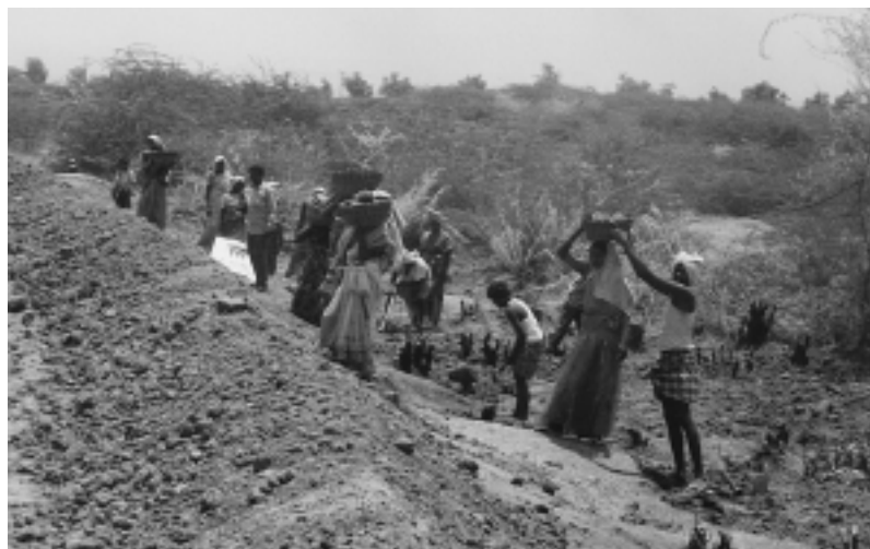
Arbeiten am Bau eines Dorfteiches
