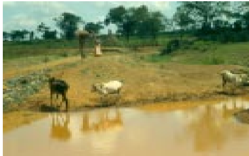
Wasserrückhaltebecken versorgt Mensch und Tier mit Wasser
